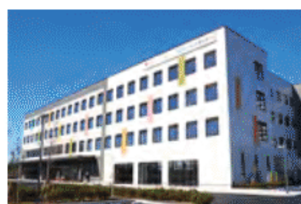
タムス浦安病院 《内科》《緩和ケア科》 《リハビリテーション科》 千葉県浦安市高洲 7-2-32 ☎047-312-6765
