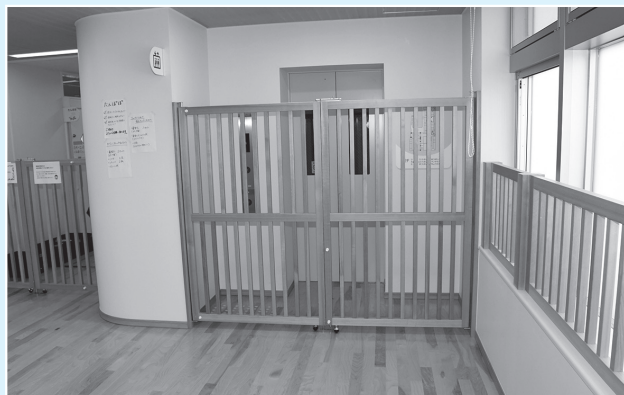
▲施設内には車いす対応のエレベーターを設置
